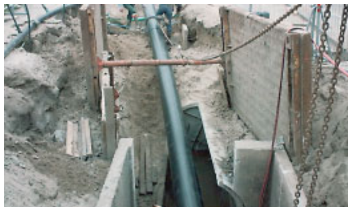
De nieuwe HDPE rioolbuis wordt ingebracht.
