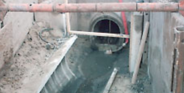
De schuimbeton-onderlaag is aangebracht.
