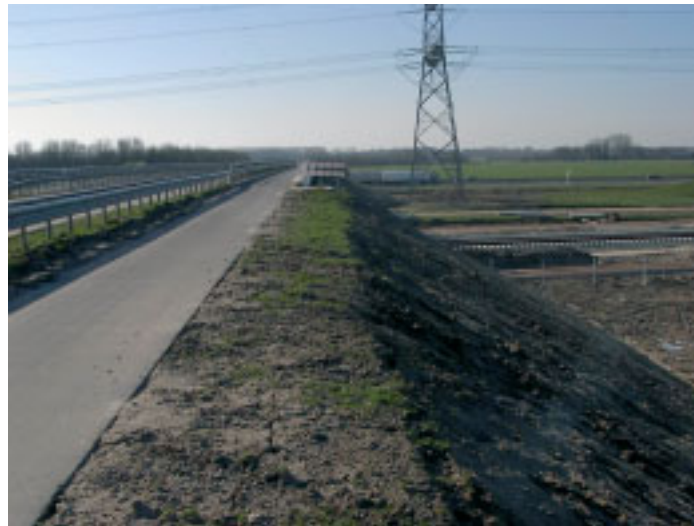
Het resultaat van alle inspanningen: een 'licht' verhoogde brug die straks het containervervoer over de Betuwelijn geen strobreed in de weg legt.
