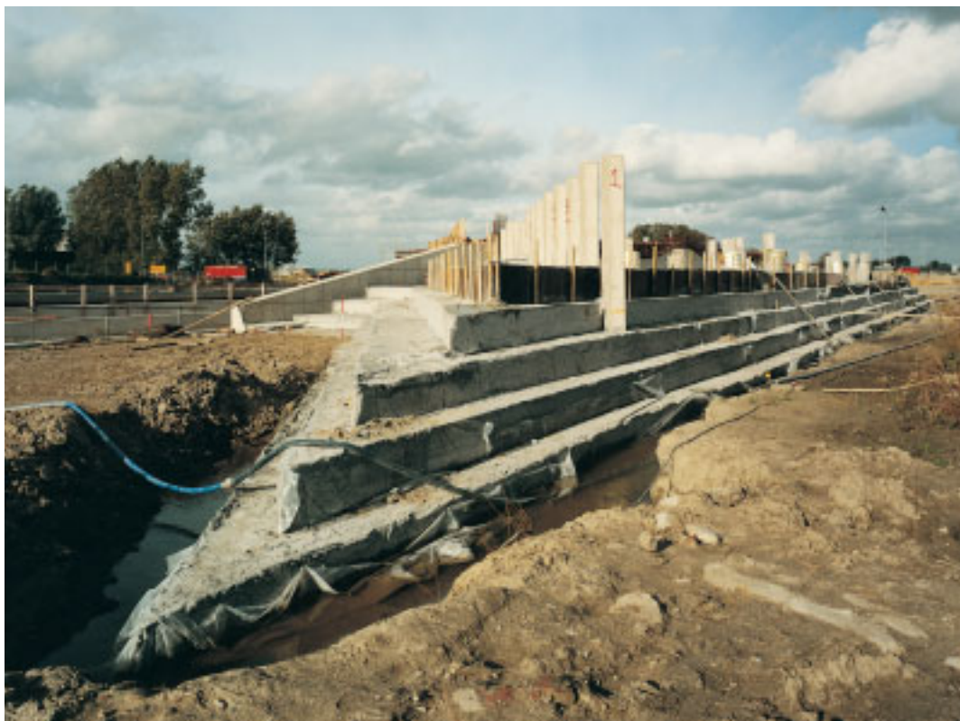
Laagsgewijze aanvulling van 7 maal 500 mm.
