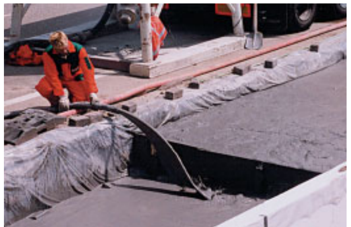
De EPS-platen werden ook gebruikt als tijdelijke bekisting voor het schuimbeton.
