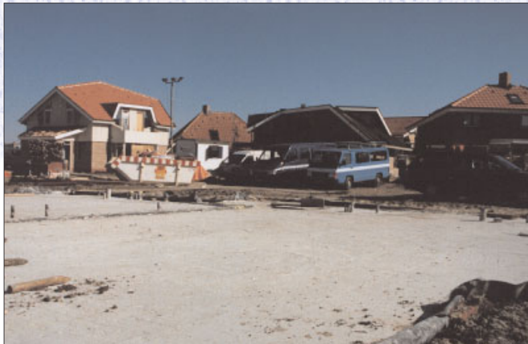
Op de achtergrond op schuimbeton gefundeerde woningen in afbouwstadium (projectfase I).
