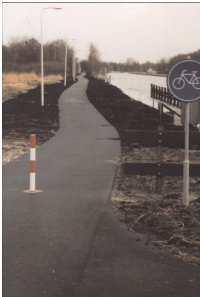
Schuimbeton als fietspad-fundering in natuurgebied 'de Weerribben' te Overijssel.
