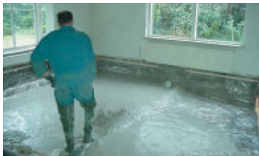
Aanbrengen schuimbeton
