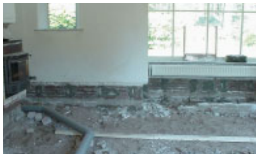
Ondergrond en riolering.
