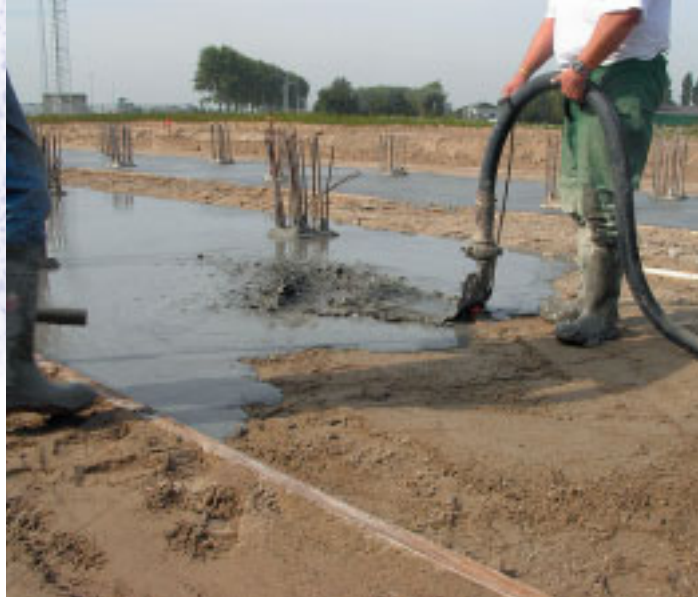
De vloevloer wordt aangebracht.
