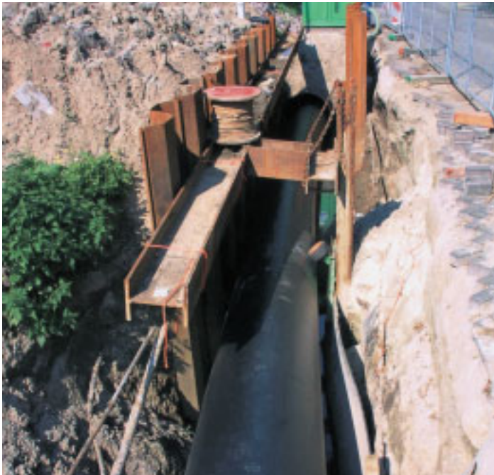
Inschuiven van de nieuwe binnenbuis in de bestaande buitenleiding
