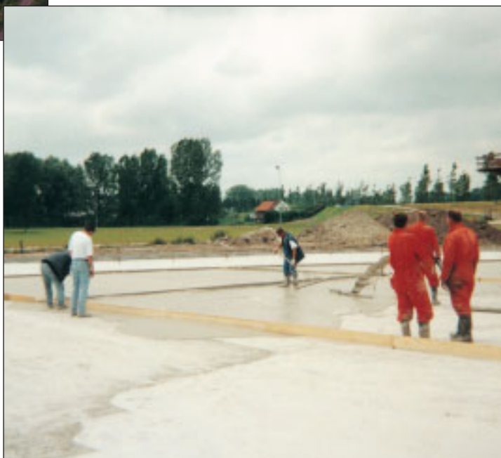
Bij de buitenbaan wordt het schuimbeton gefaseerd opgespoten.
