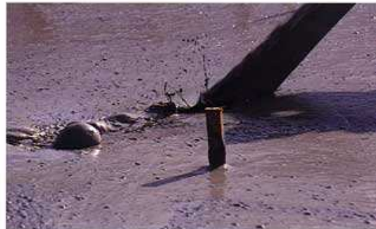
Huid Na het storten vormt zich een huid op het schuimbeton. De ingemengde lucht ontwijkt voor een deel uit het bovenste laagje. Maar dat heeft geen invloed op de kwaliteit van het pakket.
