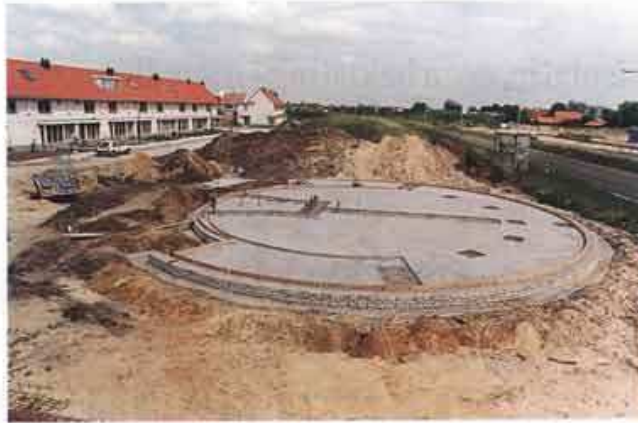
Bres in wal De plattegrond laat zich lezen in de fundering. Het (nog aan te leggen) wandelpad over de geluidswal wordt gewoon doorgezeten over het dak van de peuterspeelzalen.
