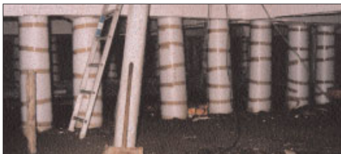
De paalfundering is ingepakt, zodat deze los blijft van het schuimbeton.
