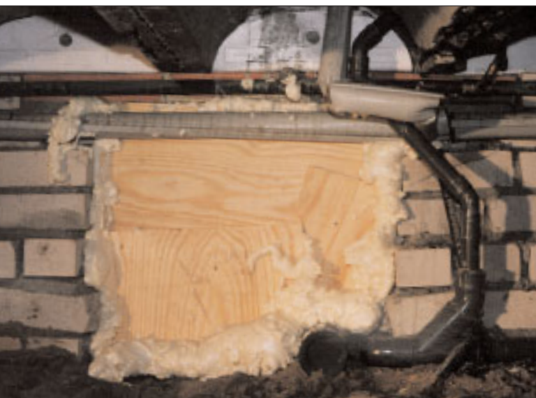
Aangetaste kwaaitaalvloer.
