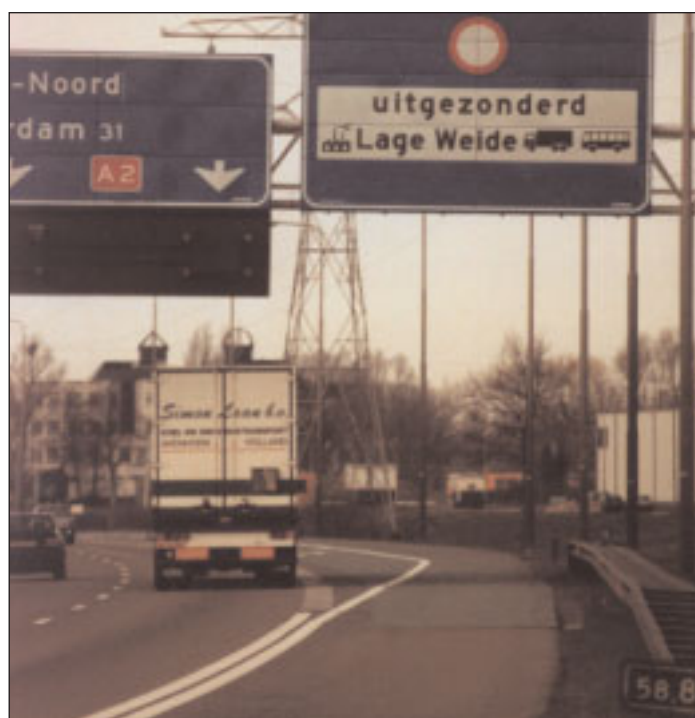
De pendelplaat rust op een fundering van schuimbeton.
