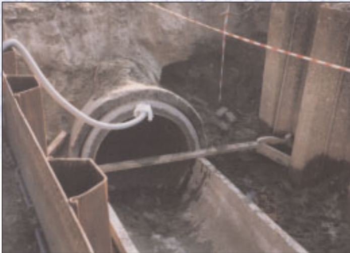
Het vullen van de ruimte tussen de buizen.
