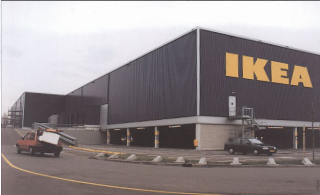
De aanvoer-/afvoerweg naar de laad- en losperrons is gefundeerd op PS hardschuim en schuimbeton.
