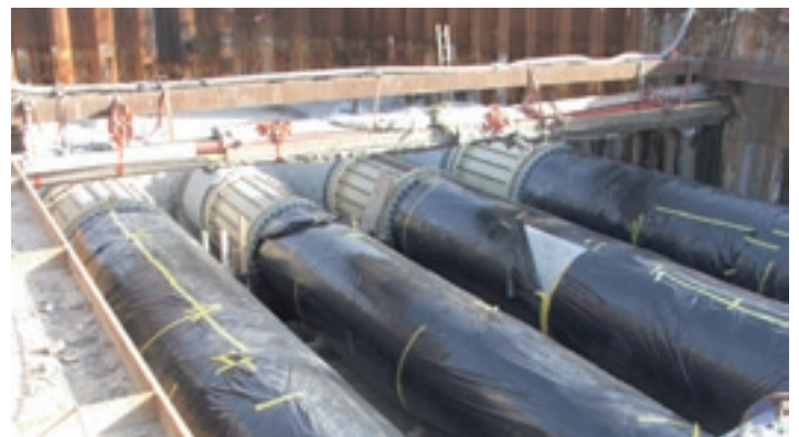
Persleidingen naderen ‘mannelijke aan mannelijke’ AWZI Harnaschpolder.
