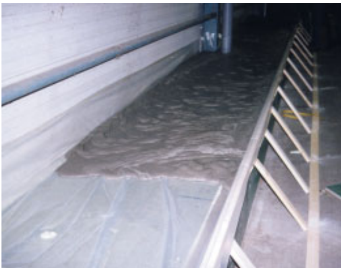
Schuimbeton op weg naar ...
