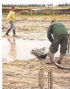
Het 'werkvloeren' van het tracé HSL-Zuid met licht opgeschuimde vloeispecie.
