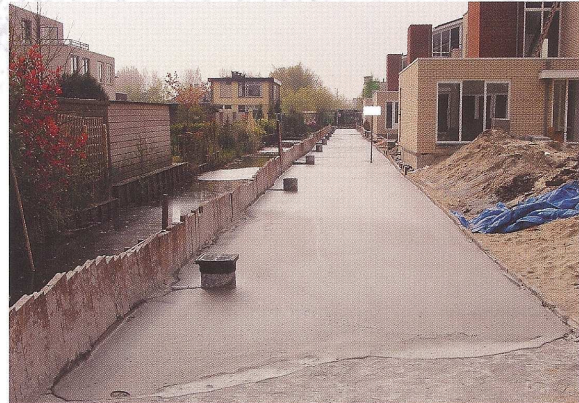
Dunvloeibaar beton op dik water.
