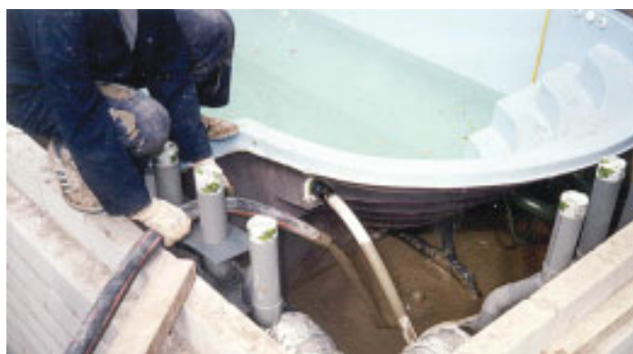
De ruimte tussen zwembad en omringing wordt eenvoudig gevuld met schuimbeton.
