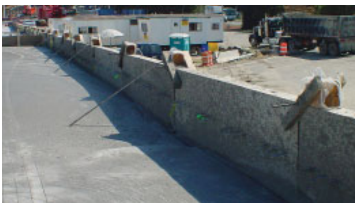
Schuimbetonvulling achter panelen.
