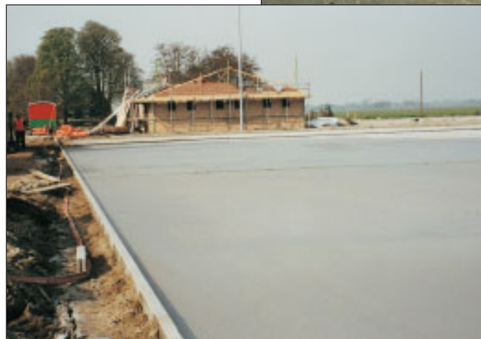
De schuimbetonplaat vóór en na perforatie.
