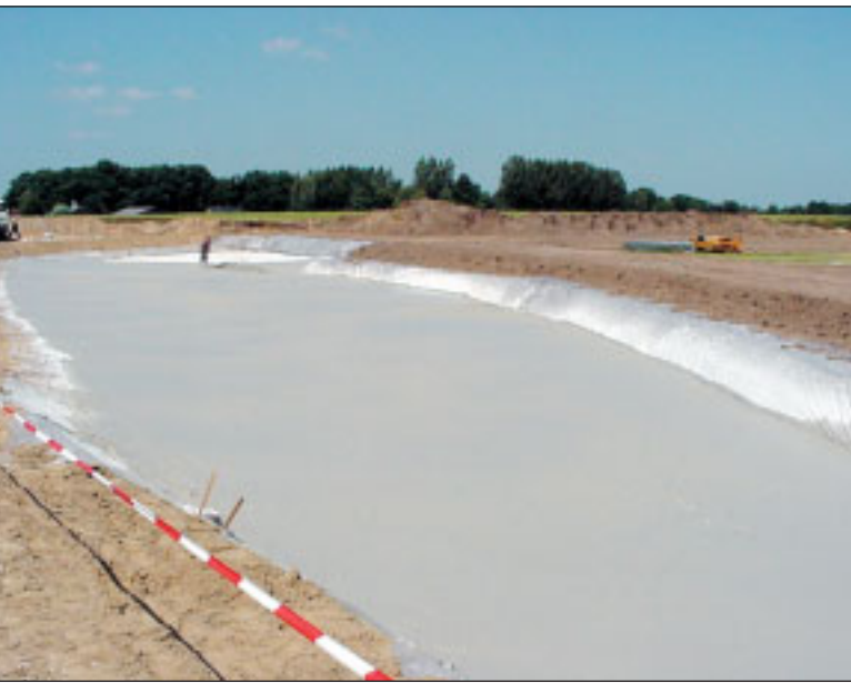
Het schuimbeton wordt laagsgewijs aangebracht.
