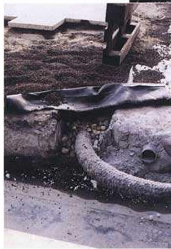
Subgoot Aansluiting van een subgoot met grind en drainagebuis op een hoofdgoot, die later ook met buizen en grind gevuld wordt. Links en rechts van de subgoot dikke lagen schuimbeton met daaroverheen een filterdoek en een laag lavasplijt.
