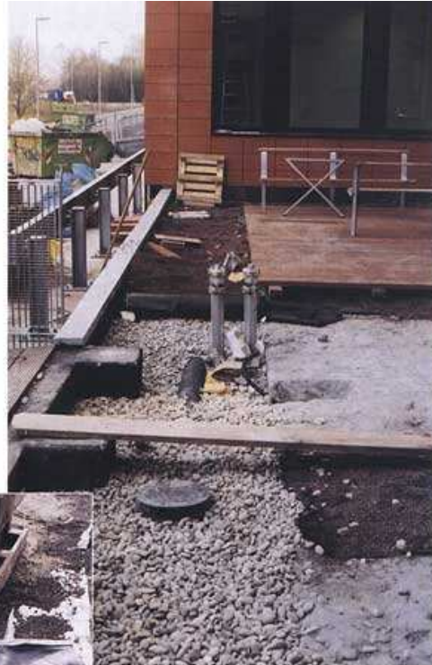
Hoofdgoot Een hoofdgoot langs de rand van het dek gevuld met grind, die het water afvoert naar de reguliere hwa-standleidingen. Rechts op de voorgrond zijn nog vakken schuimbeton te zien. Op de achtergrond zijn al houten vlonders aangebracht.
