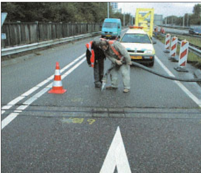
Aanbrengen van het schuimbeton via in het wegdek gemaakte gaten.
