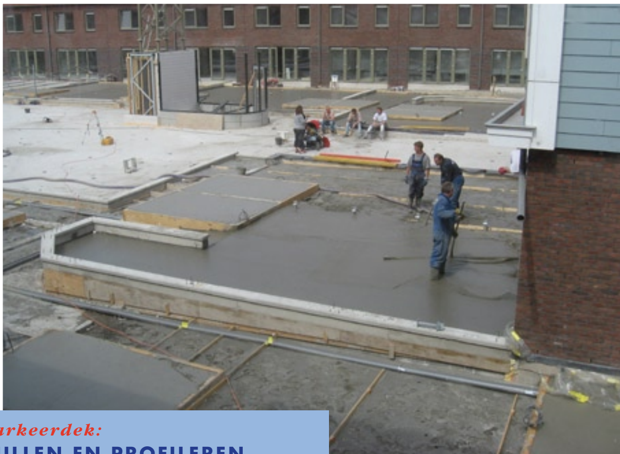
Aanbrengen schuimbeton.
