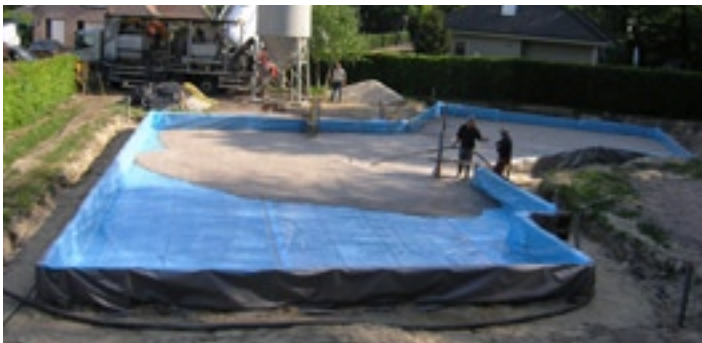
Aanbrengen schuimbeton in ‘badkuip’.
