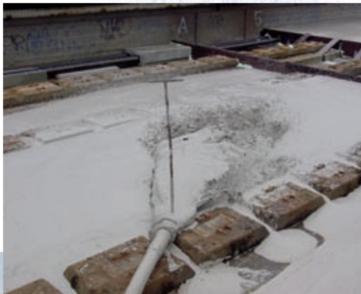
Nagenoeg zelfnivellerend schuimbeton vult zich sluitend op de betonondergrond.
