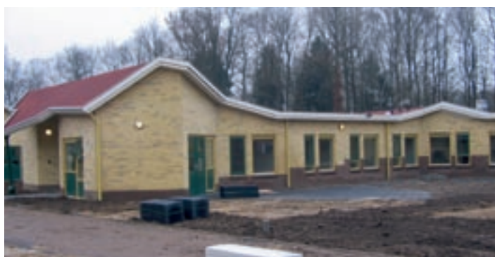
Enkele woningen in woonzorgcomplex De Losserhof bij oplevering.
