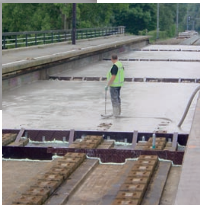
Bekisting houdt de opleggingen/dilataties vrij van schuimbeton.
