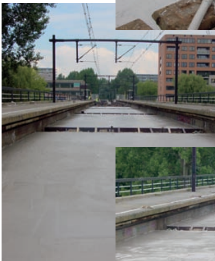
Schuimbetonverhoging van het spoor is gereed.
