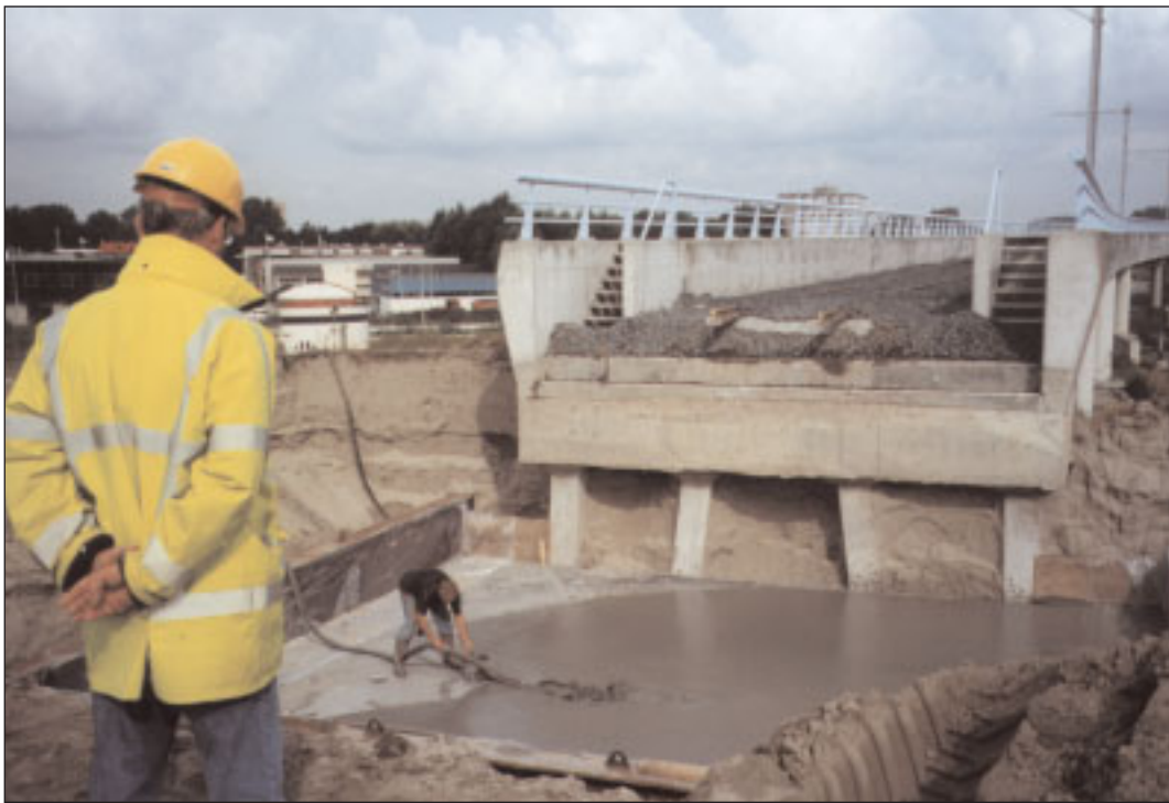
Aanbrengen van een van de vier lagen schuimbeton bij knooppunt HSL/Betuweroute in Barendrecht.
