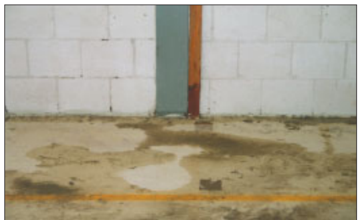
De vloer nadat deze is 'gelift'.
