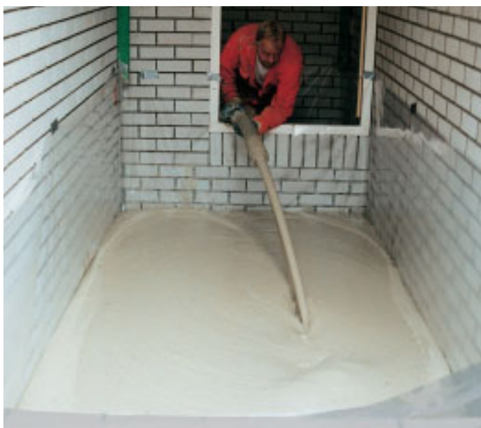
De 51 cm dikke vulvloer wordt per verblijfsruimte in één laag opgebracht.
