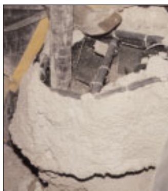
De sculpturen worden gevuld met schuimbeton.
