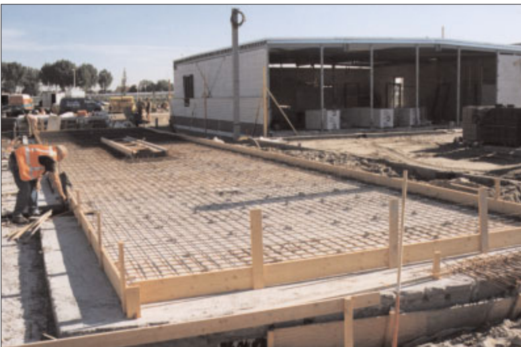
Uniek: alle delen van dit Shell tankstation zijn gefundeerd op schuimbeton.
