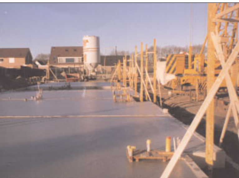
Schuimbeton gestort tussen de eerste laag metselwerk.
