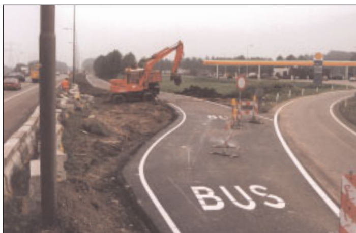
... kon de busbaan worden geasfalteerd.
