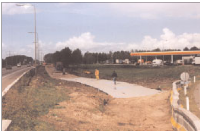
Na aanbrengen van het schuimbeton en de profileringslaag ...
