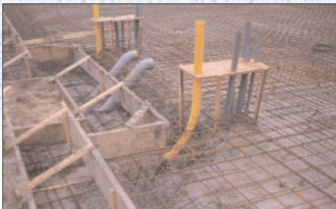
Bekisting gereed voor het storten van de constructieve vloer.
