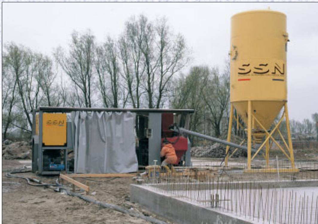
'Verser' is niet mogelijk: schuimbeton-productie op locatie, met een droge-stoffen-silo.
